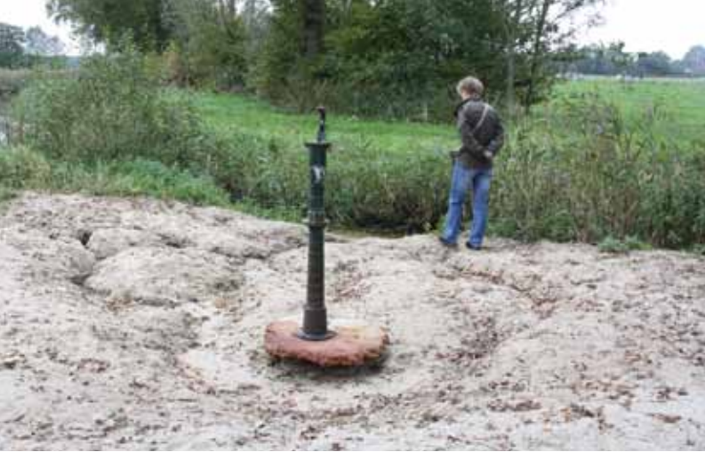
Zand rondom een waterpomp kan snel uitspoelen.
